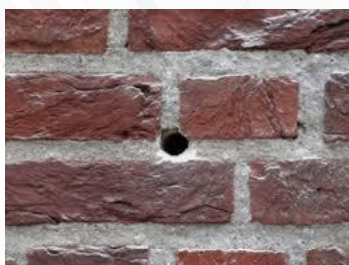
Fig. 29: een geboorde vulopening
