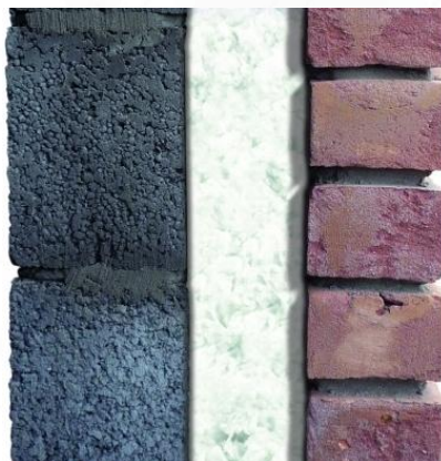
Fig. 33: met minerale wol gevulde spouw
