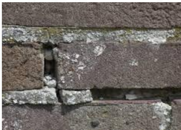
Fig. 6: gebrekkig voegwerk
