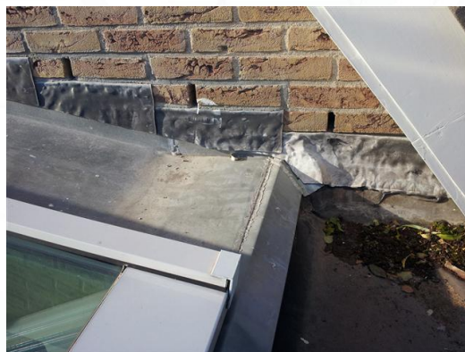
Fig. 18: loodslabben i.c.m. een afwateringsopening
